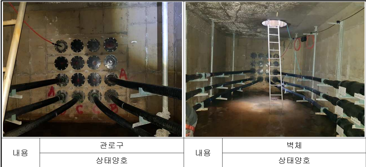
【사진 11.62】 맨홀 내부 주요 손상
